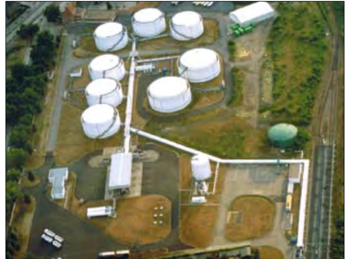
Abb. 8.3-1 Tanklager Bremer Straße, hydraulische Sicherung eines Grundwasserschadens
