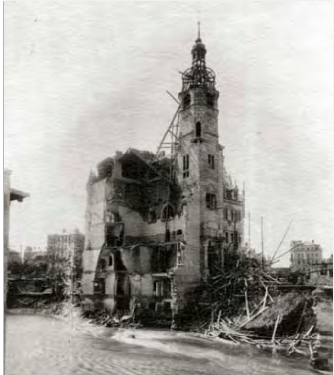
Abb. 7.2-10 Hochwasser der Weißeritz – das teilzerstörte Lößtauer Rathaus (Quelle: Stadtplanungsamt)
