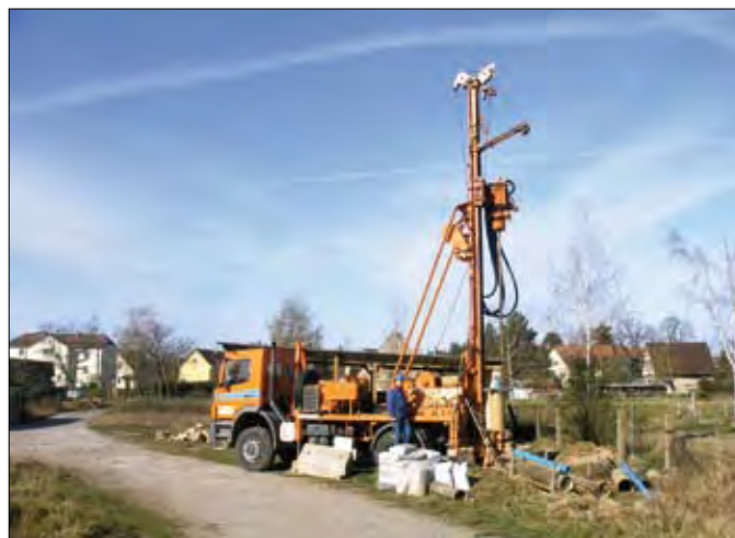
Abb. 6.2-19 Bohrgerät bei der Errichtung einer neuen Grundwassermessstelle
