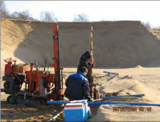
Abb. 8.3-8 Erkundung der Bodenluft im Sandtagebau an der Radeburger Straße
