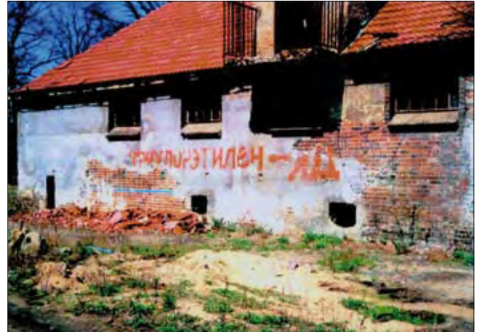
Abb. 8.3-12 Außenansicht des Gebäudes der ehemaligen Chemischen Reinigung im Kasernengelände der WGT-Liegenschaft mit der kyrillischen Aufschrift „Trichlorethylen – Gift“
