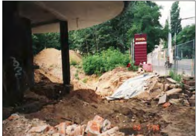
Abb. 8.3-10 Sanierung einer Tankstelle im Freistellungsverfahren
