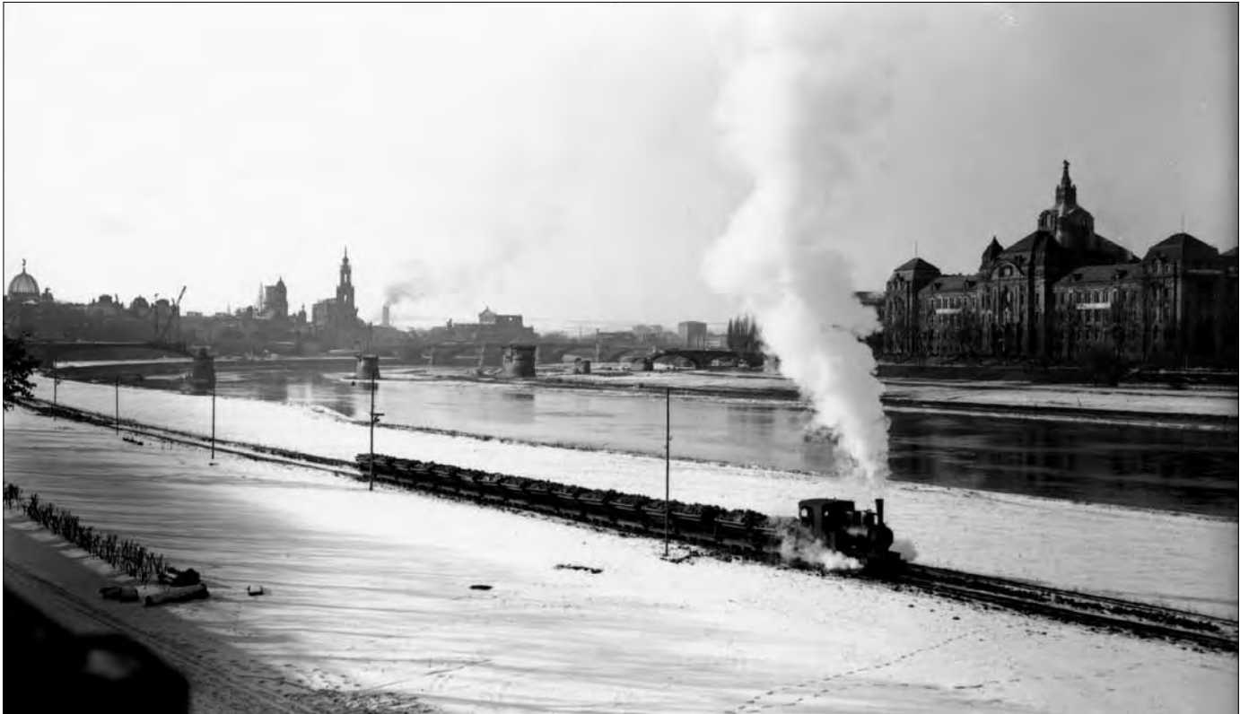
Abb. 8.3-3 Die Trümmerbahn auf den Elbwiesen
