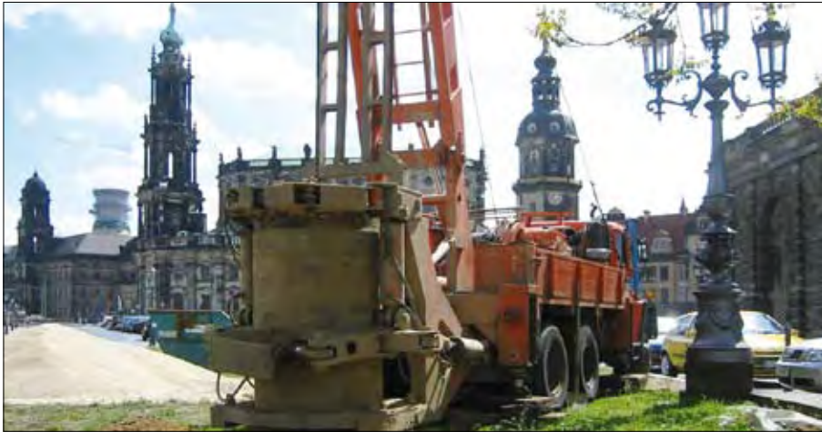
Abb. 7.3-11 Brunnenbau an der Semperoper
