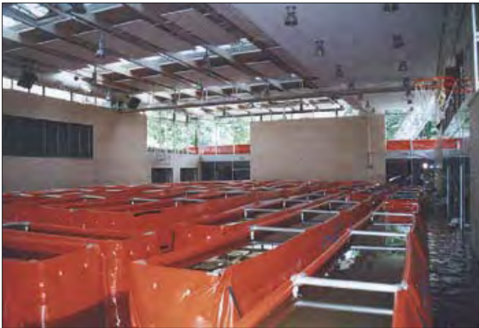
Abb. 6.2-12 Grundwasserbedingter Auftrieb und Bauwerksicherung durch Quick-Dämme am St.-Benno-Gymnasium (Quelle: http://www.benno-gym.de )
