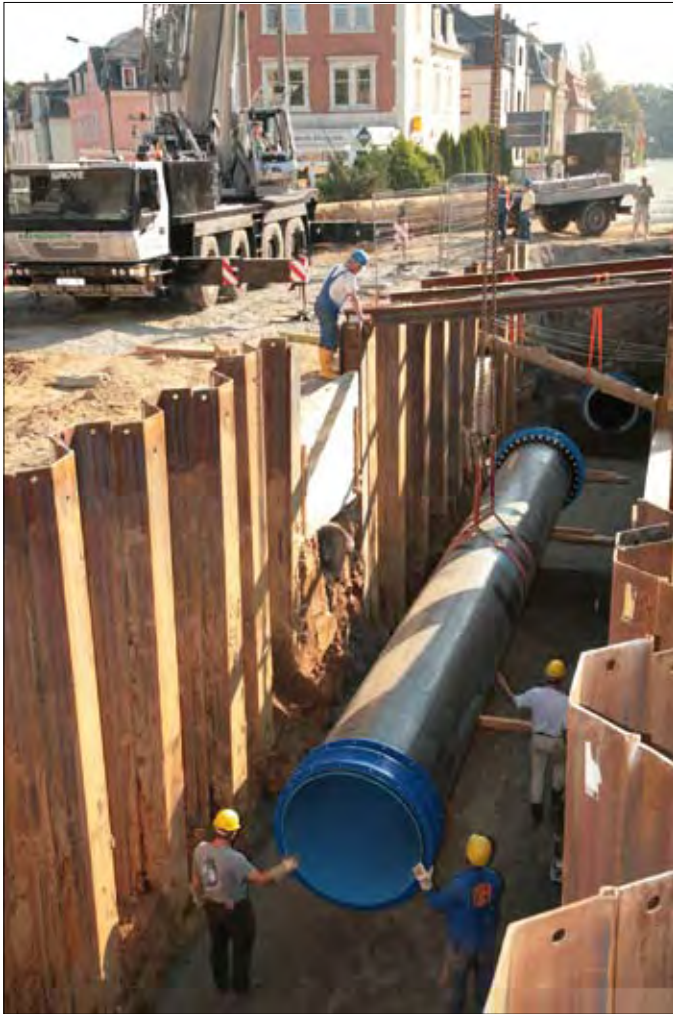
Abb. 7.2-15 Austausch einer Trinkwasserhauptleitung (Quelle: DREWAG)
