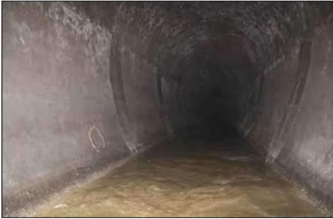
Abb. 2-5 Die Kanalisation – eines der Wassernetze im Untergrund (Quelle: SE Dresden GmbH)
