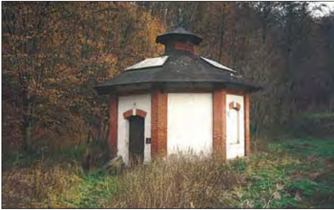
Abb. 3.2-8 Brunnenhaus für einen Rotliegend-Brunnen im Kaitzbachtal
