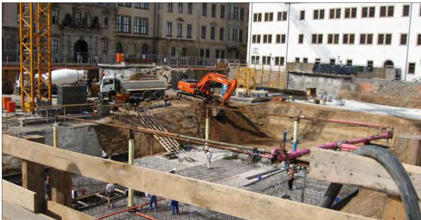
Abb. 6.1-1 Grundwasserabsenkung in einer Baugrube an der Schloßstraße
