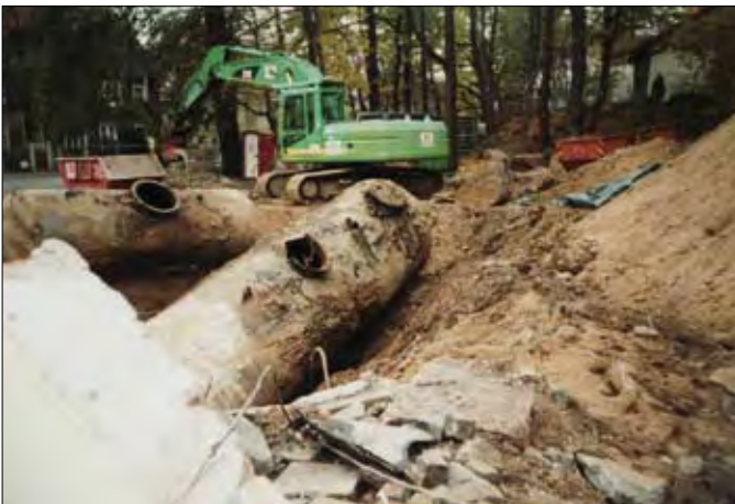
Abb. 8.3-9.1 und Abb. 8.3-9.2 Rückbau unterirdischer Tanks an ehemaligen Tankstellen
