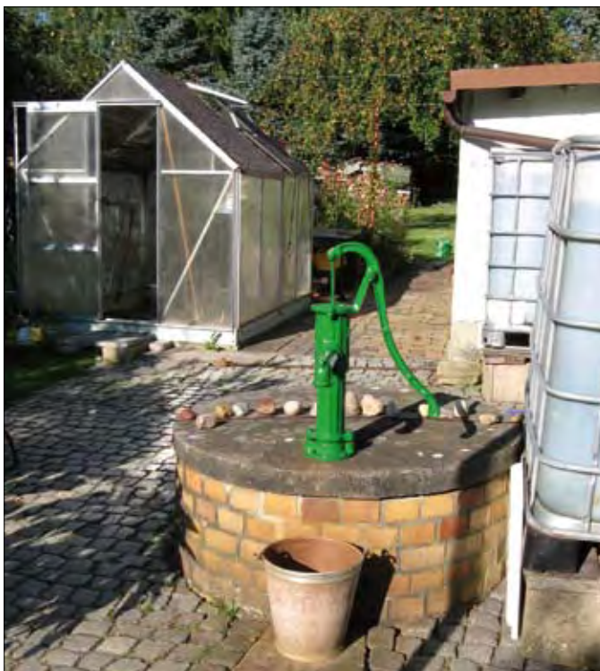
Abb. 7.2-22 Gartenbrunnen mit Schwengelpumpe
