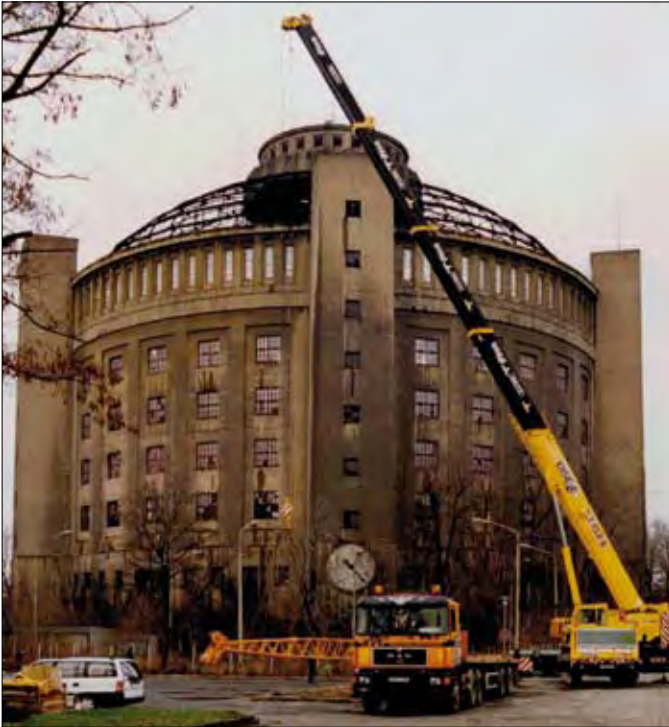
Abb. 5.3-7 Alter Gasspeicher im ehemaligen Gaswerk Reick
