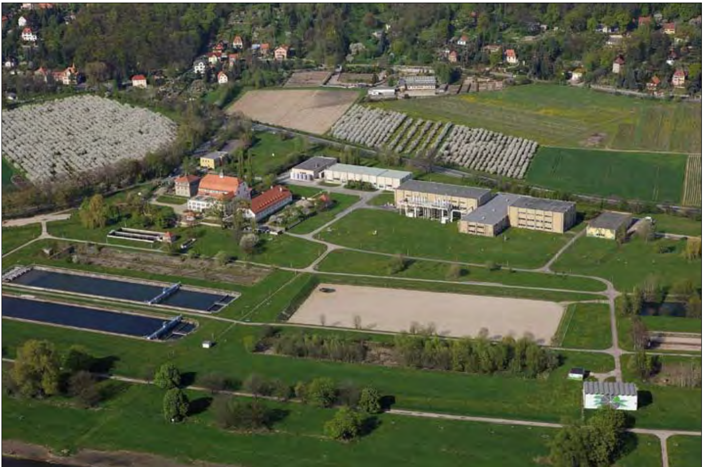
Abb. 7.2-9 Das Wasserwerk Hosterwitz (Quelle: DREWAG)
