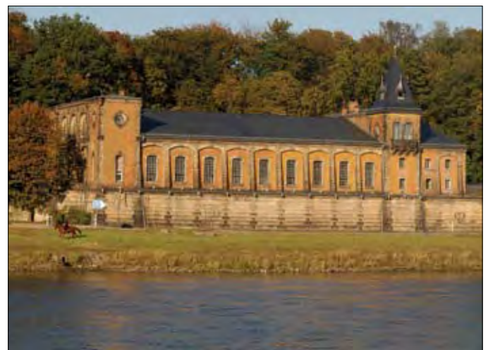
Abb. 7.2-5 Das Wasserwerk Saloppe (Quelle: DREWAG)
