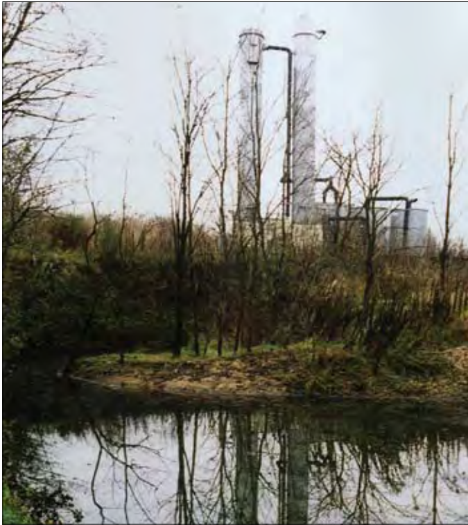
Abb. 8.3-14 Blick auf die Grundwasser-Sanierungsanlage am Diebweg
