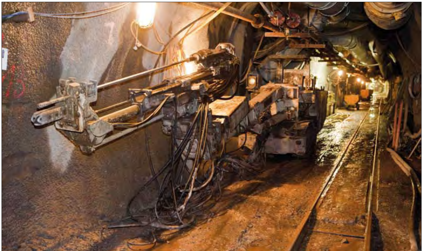
Abb. 3.2-6 Schwere Technik im WISMUT-Stolln (Quelle: Thomas Ackermann, Wismut GmbH)
