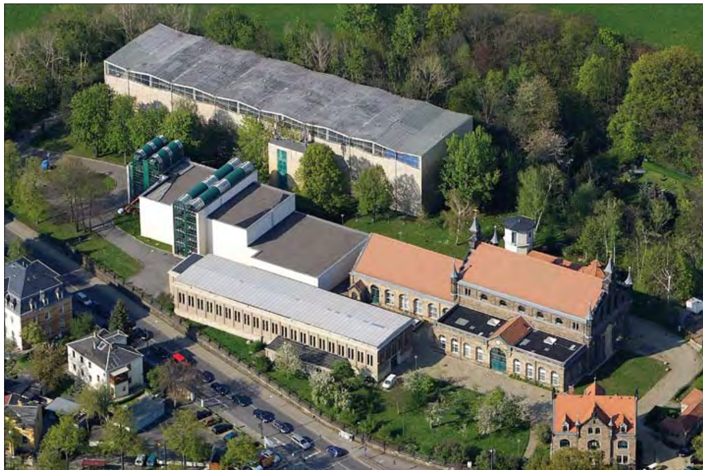
Abb. 7.2-7 Das Wasserwerk Tolkewitz von oben. Die alte Halle in der Bildmitte wurde inzwischen rückgebaut. (Quelle: DREWAG)
